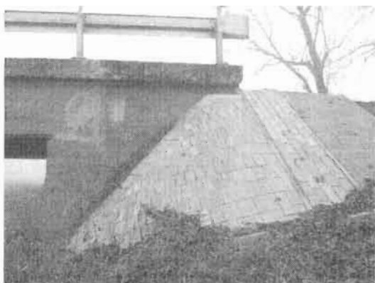
Most na drodze powiatowej nr 3670P w m. Nietrzebanowo
