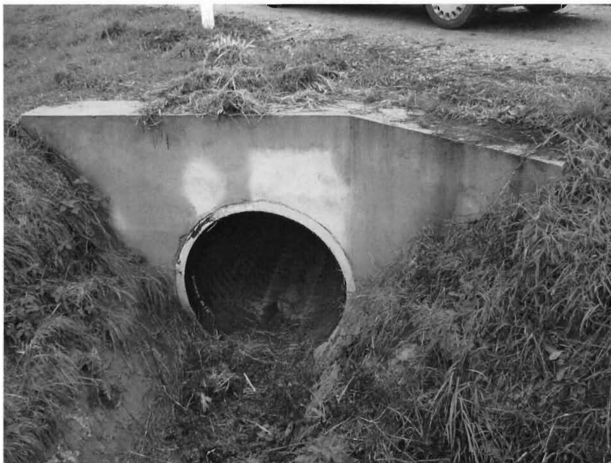
Zdjęcie nr 2 – Przepust w drodze dojazdowej do śluzy.
