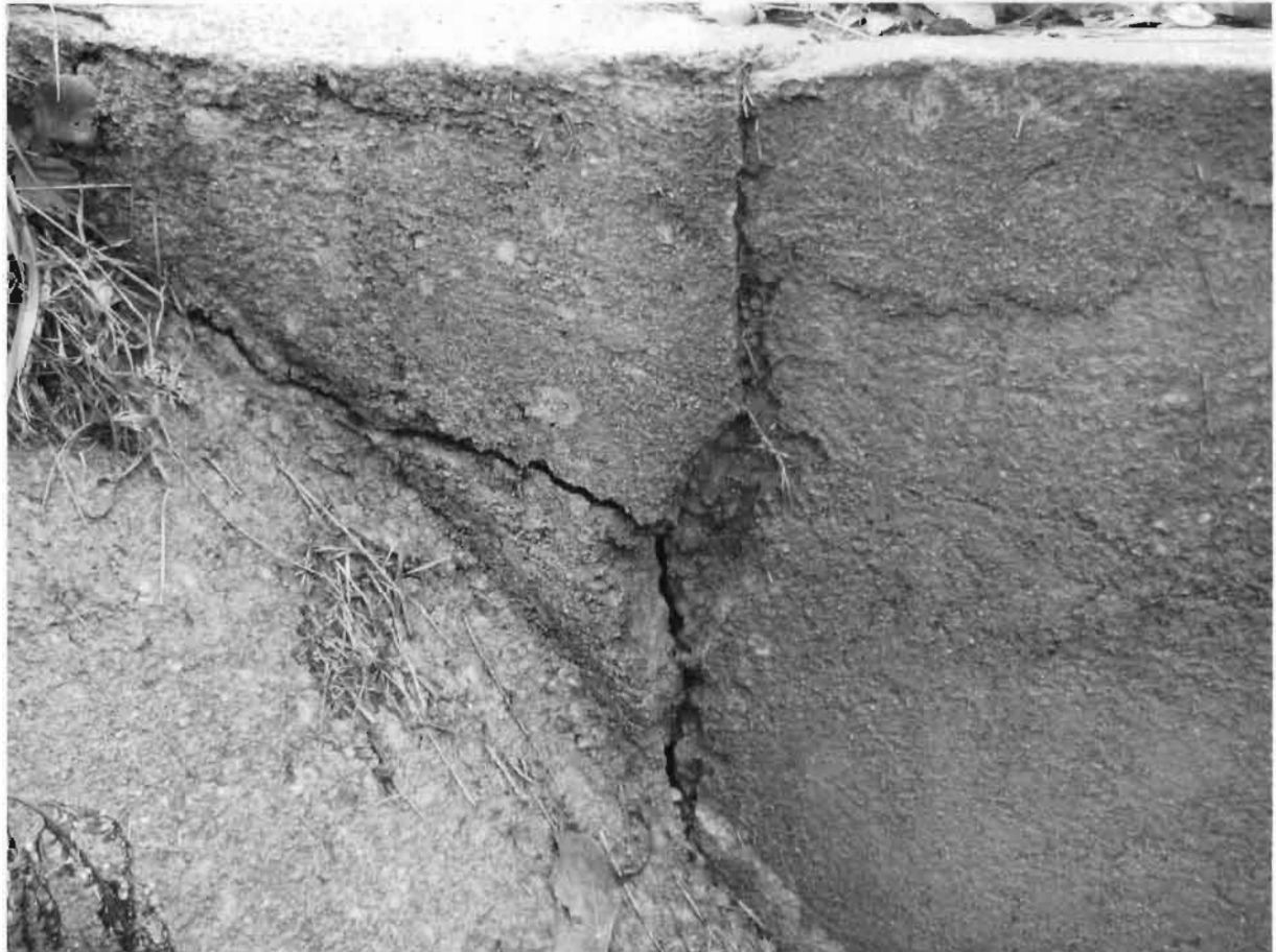
Zdjęcia nr 4 – Widoczne pęknięcia ścian czołowych.
