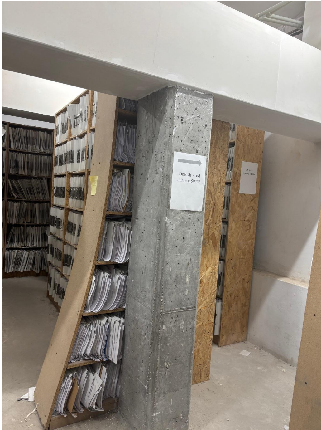
Nr 4: Pomieszczenie nr 2:
